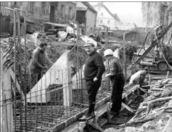
Abb. 21: Hochwasserschutzmaßnahmen an der Vils in Bau (Ausführung 1968 / 69)
