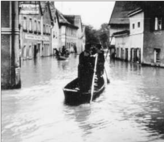
Abb. 27: Überflutete Ortsdurchfahrt (Bundesstraße B 388) 1954
