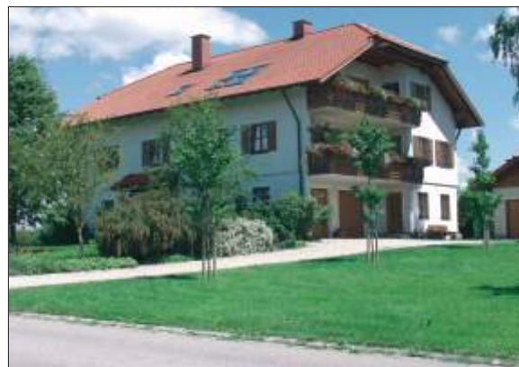
Abb. 11: Neu errichtetes Anwesen in Reding. Geländeanhebung im Bereich des Wohnhauses
