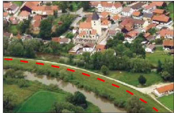
Abb. 18: Hochwasserschutzdamm der Ortschaft Walchsing (Gemeinde Aldersbach)
