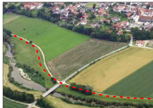
Abb. 19: Hochwasserschutzdamm im Bereich der Ortschaft Pörndorf (Gemeinde Aldersbach)
