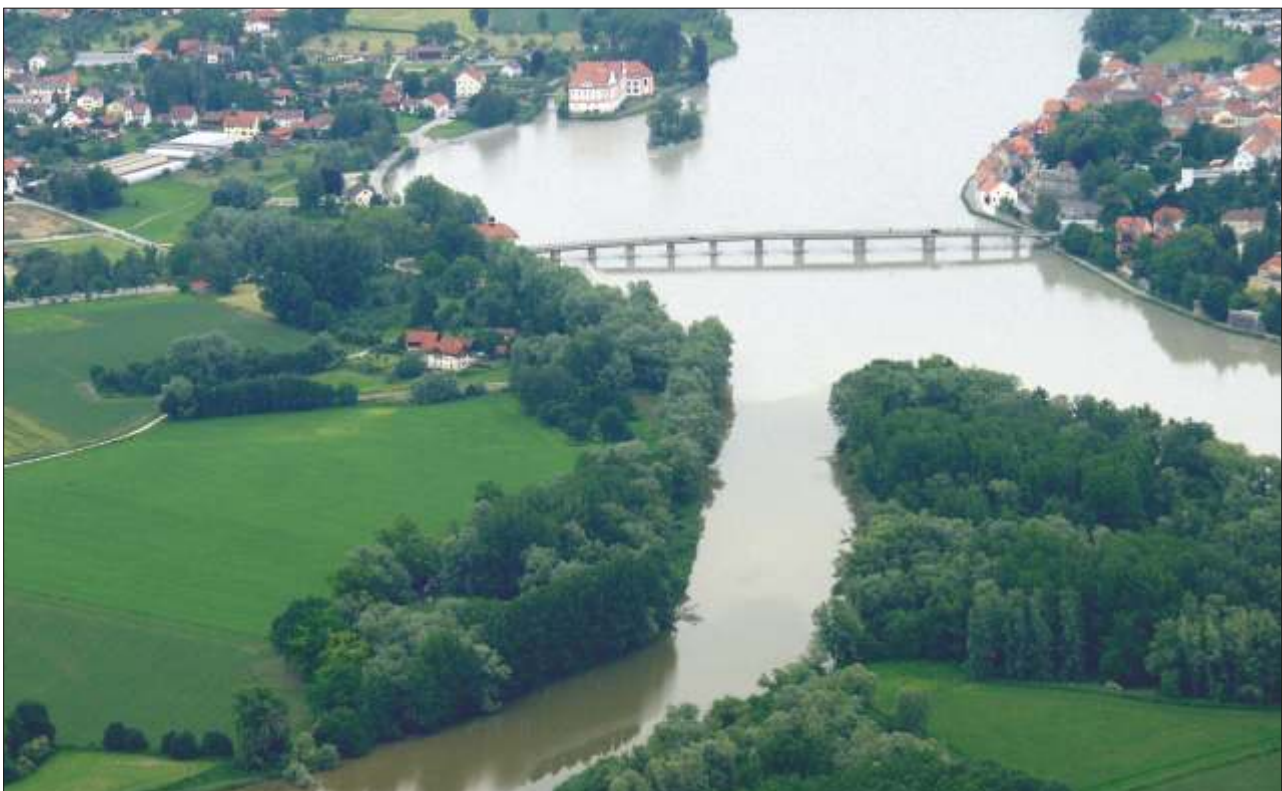
Abb. 13: Aktuelle Aufnahme vom Juli 2004: von links mündet die Rott in den Inn. Im Zuge der Hochwassersanierung sind Teile der Bebauung von Neuhaus a. Inn abgerissen worden
