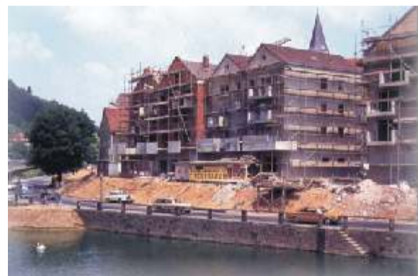
Abb. 9: Baumaßnahmen Hochwassersanierung Ilzstadt
