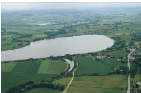
Abb. 17: Hochwasserrückhaltebecken in Marklkofen
