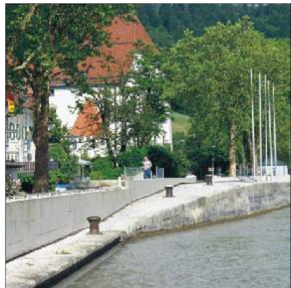
Abb.29: Neue Hochwasserschutzmauer im Bau (2004). Granitverkleidung fehlt noch.
