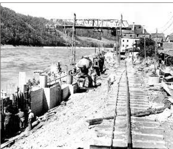
Abb. 28: Dichtungswand im Bau 1954 (Bauzeit 1952-1954)
